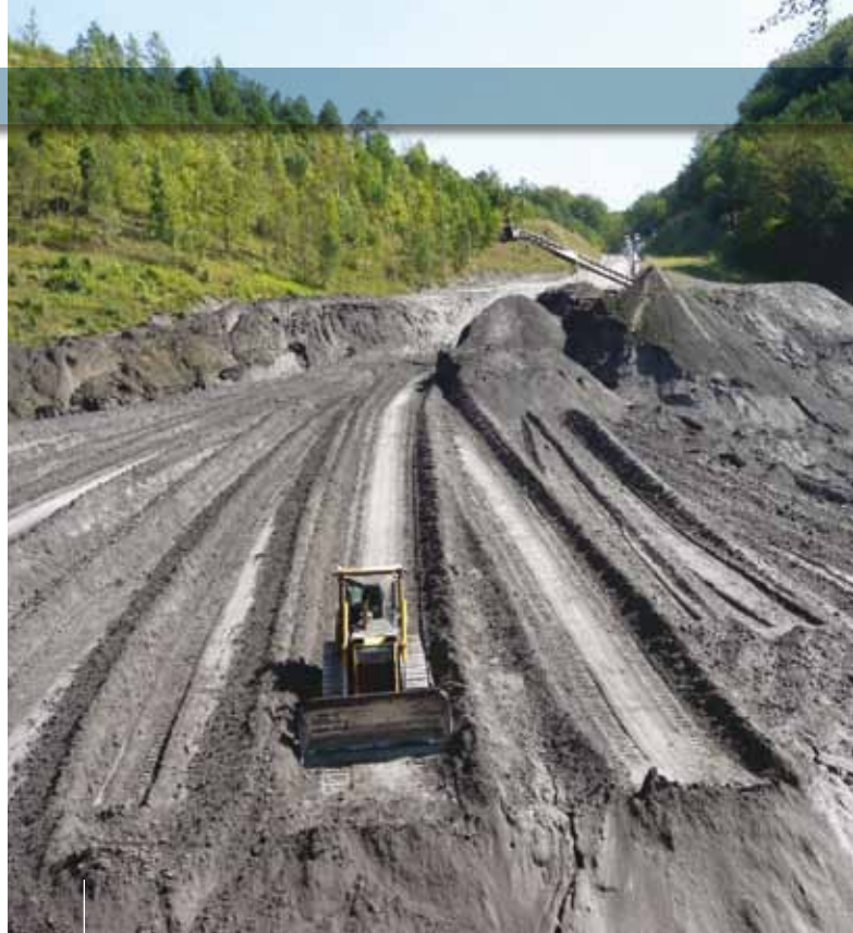
Gradnja južnega dela deponije
