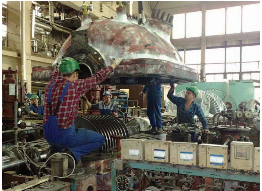
Nameščanje okrova VT dela turbine
