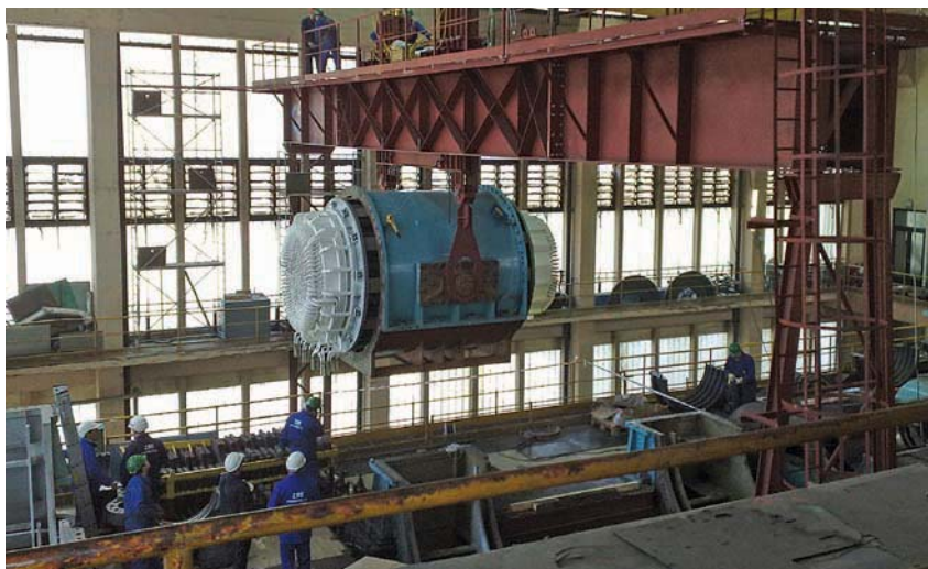
Dvigovanje novega statorja generatorja
